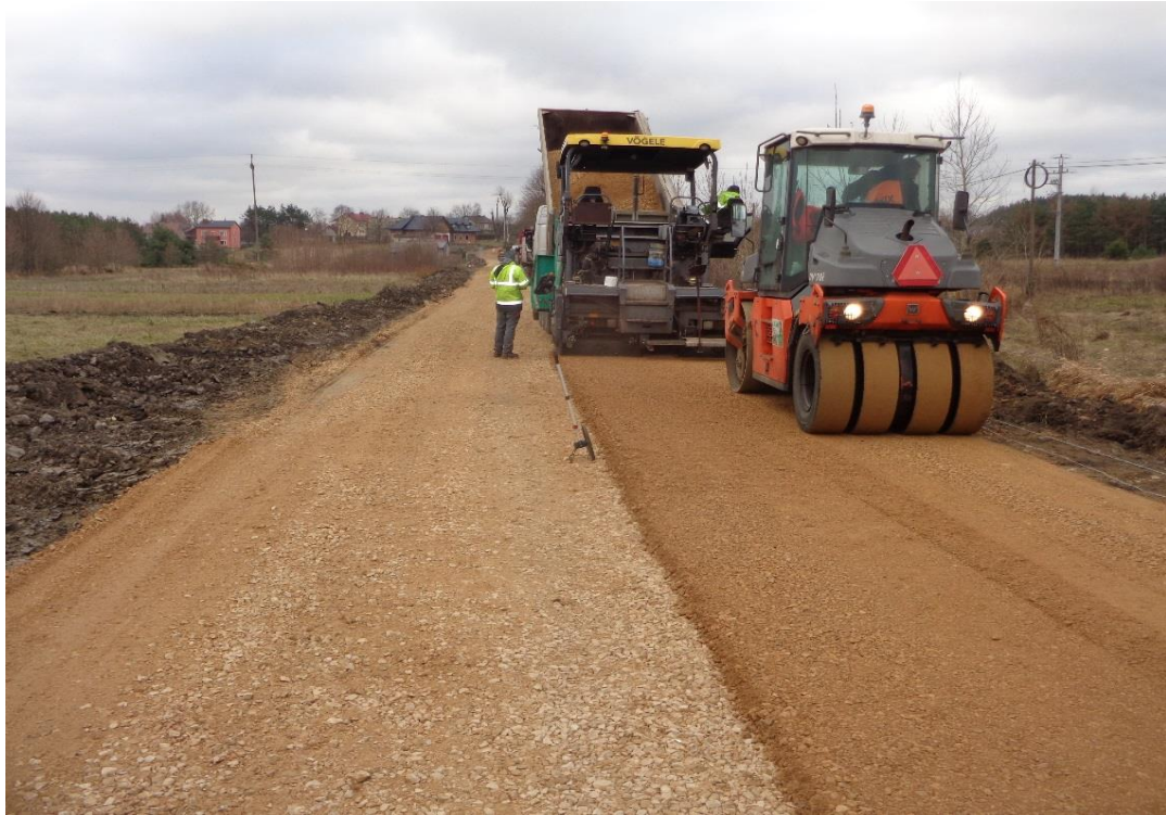
Zdj.42. DP 1093 S odc. Piasek – Czepurka w trakcie przebudowy
