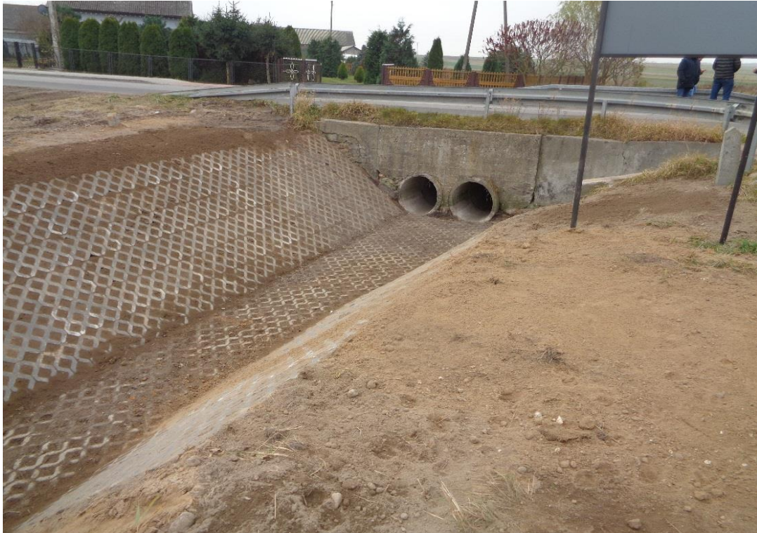
Zdj.55. Po realizacji inwestycji – po wybudowaniu odwodnienia.
