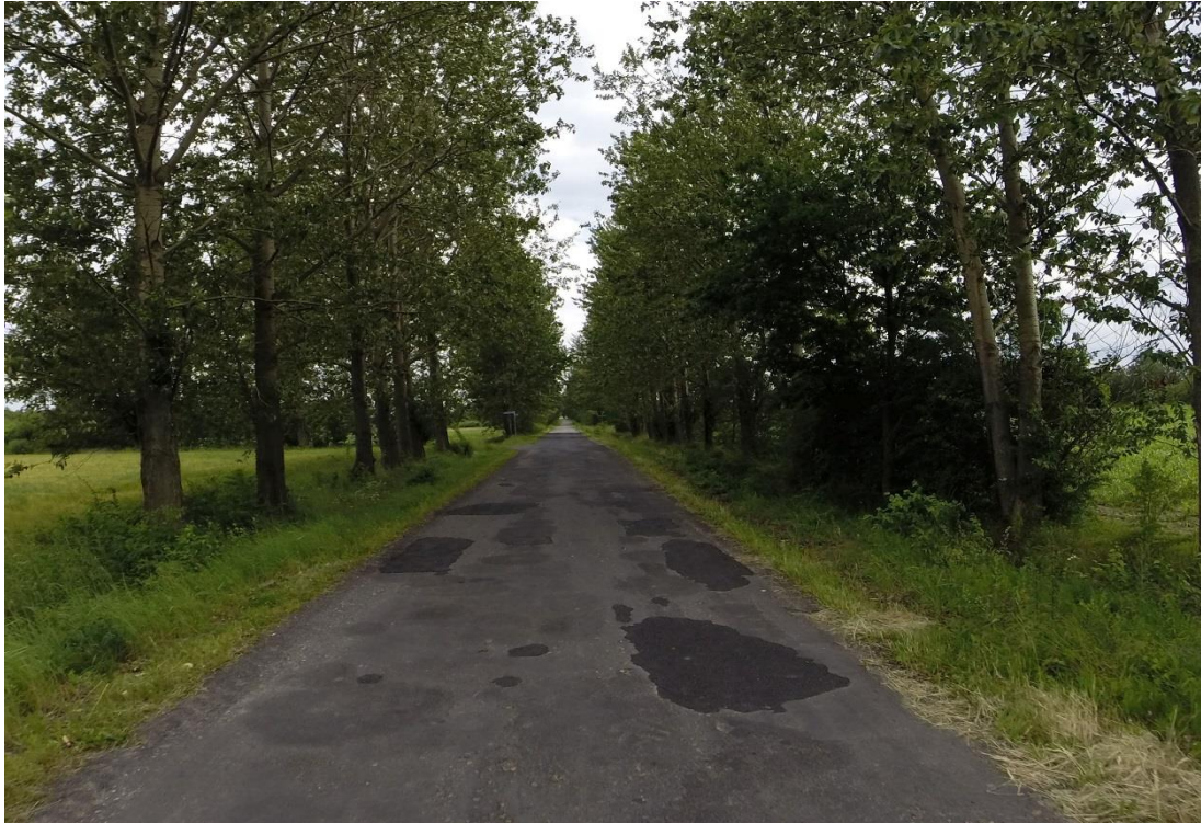
Zdj.30.DP 1070S odc. Baby – Zdrowa, gm. Kłomnice przed przebudową
