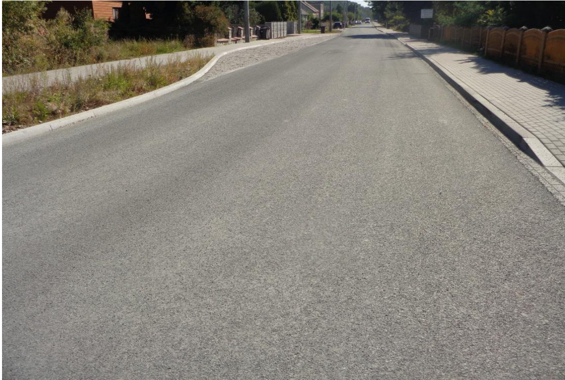
Zdj.23. DP 1057, Huta Stara A, ul. Tkacka, gm. Poczesna po przebudowie
