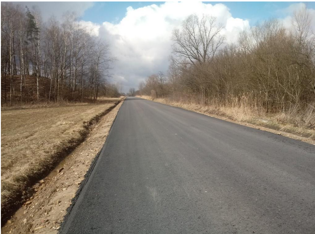
Zdj.38.DP 1056, Poczesna, ul. Łąkowa, gm. Poczesna w trakcie przebudowy
