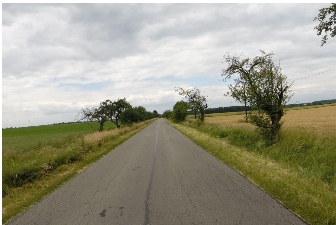
Zdj.27.DP 1025S, odc. Borowno - Kruszyna, gm. Kruszyna przed przebudową
