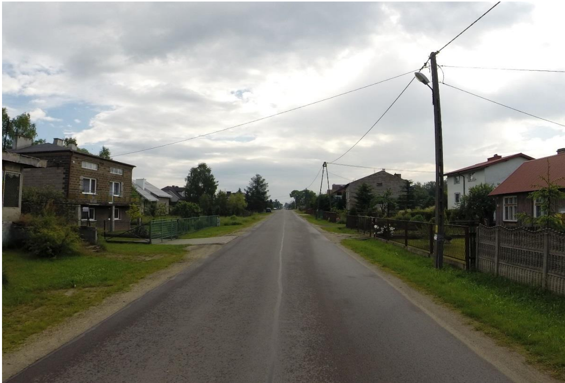
Zdj.47. DP 1042S m. Kusięta przed przebudową
