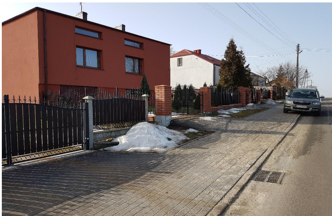
Zdj.49. DP 1042 S m. Kusięta – chodnik po przebudowie
