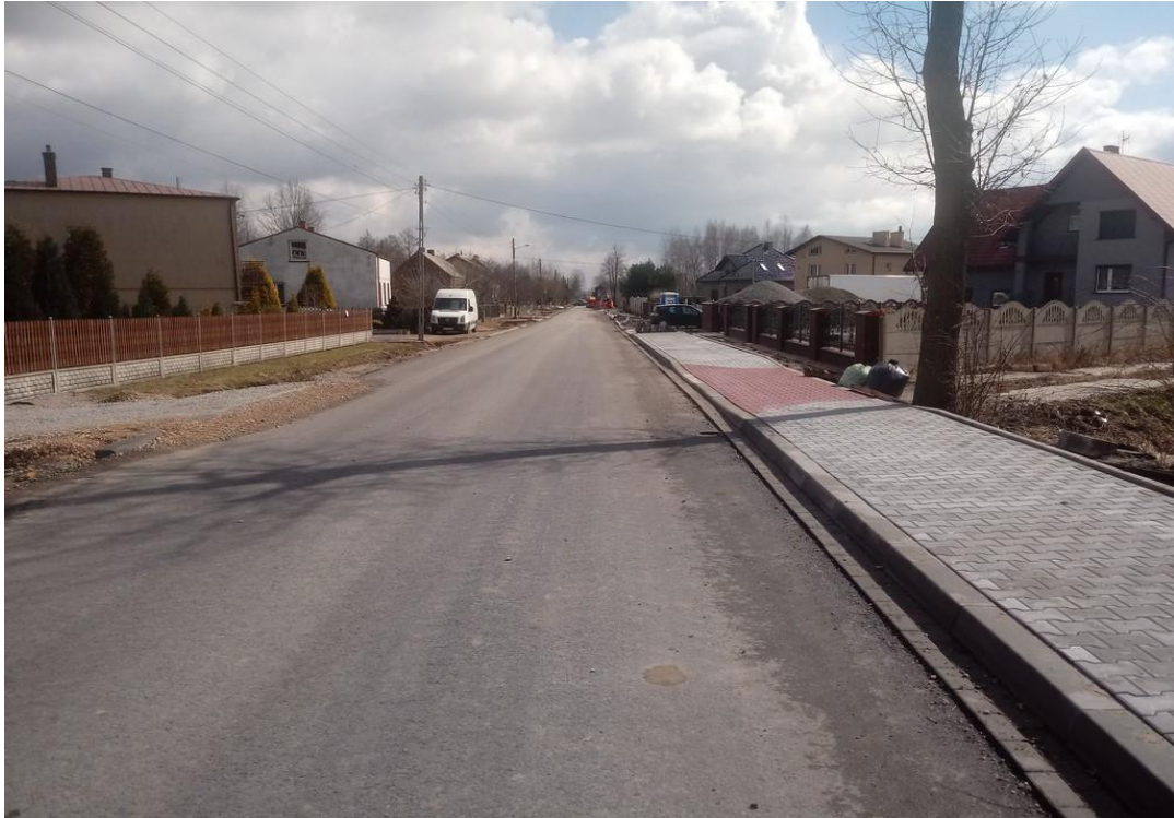
Zdj.36.DP 1056, Poczesna, ul. Łąkowa, gm. Poczesna w trakcie przebudowy
