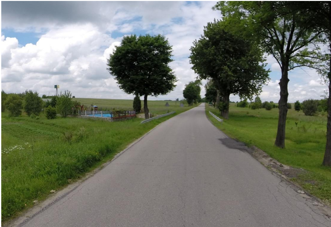
Zdj.40. DP 1093 S odc. Piasek – Czepurka droga przed przebudową
