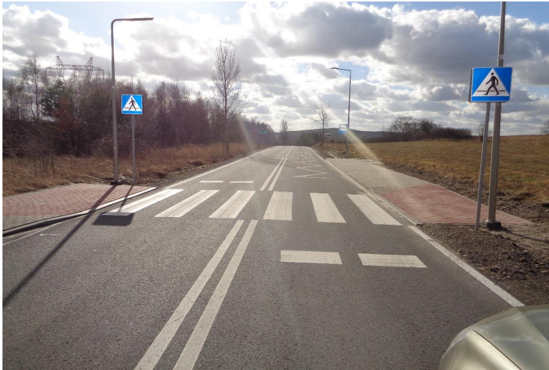
Zdj.33.DP 1037 S odc. Siedlec – Srocko przed przebudową
