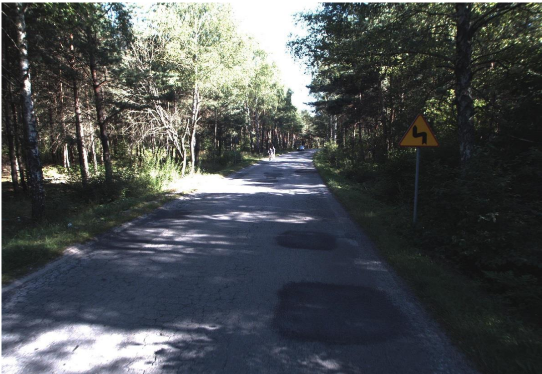
Zdj.45.DP 1013S, gm. Kamienica Polska zdjęcie przed przebudową drogi
