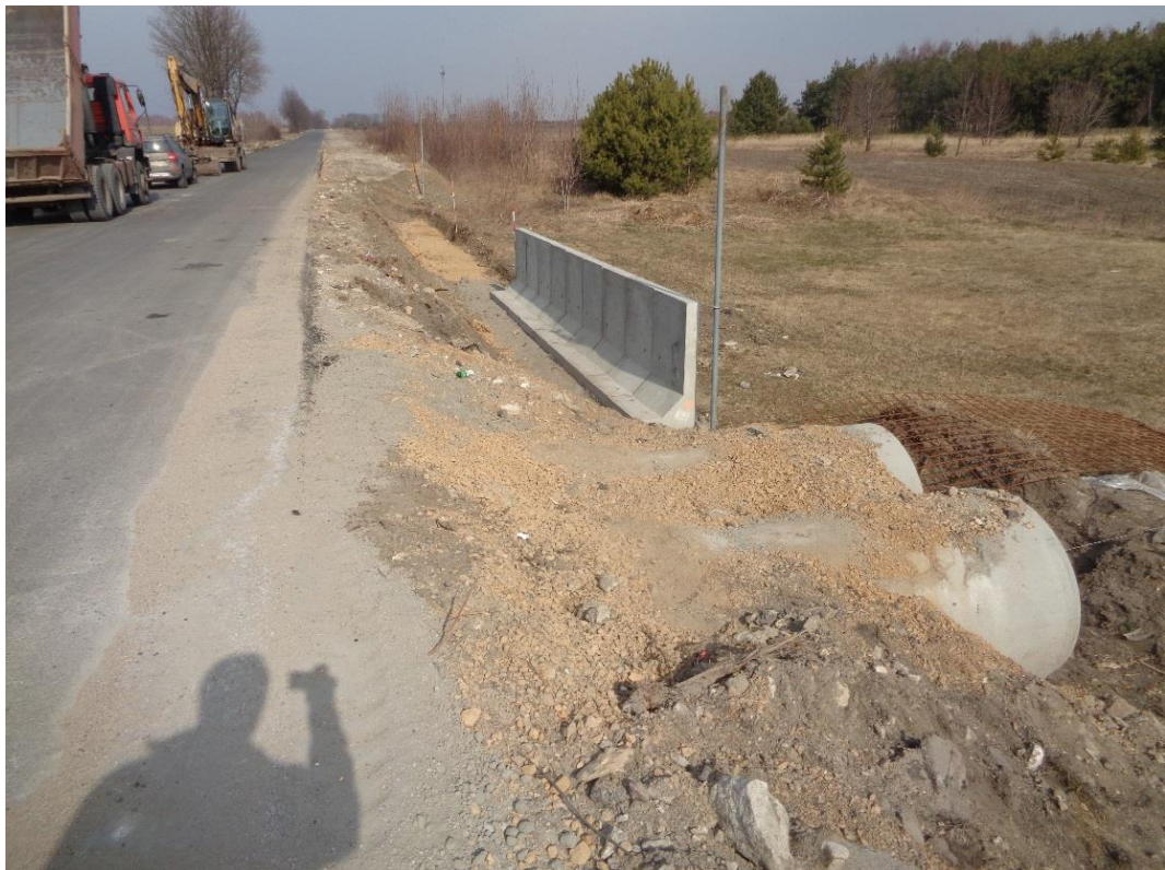
Zdj.41. DP 1093 S odc. Piasek – Czepurka w trakcie przebudowy
