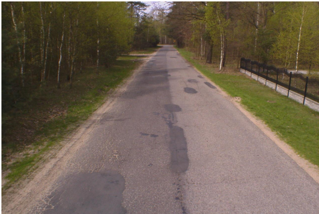
Zdj.24.DP 1056 S przed przebudową
