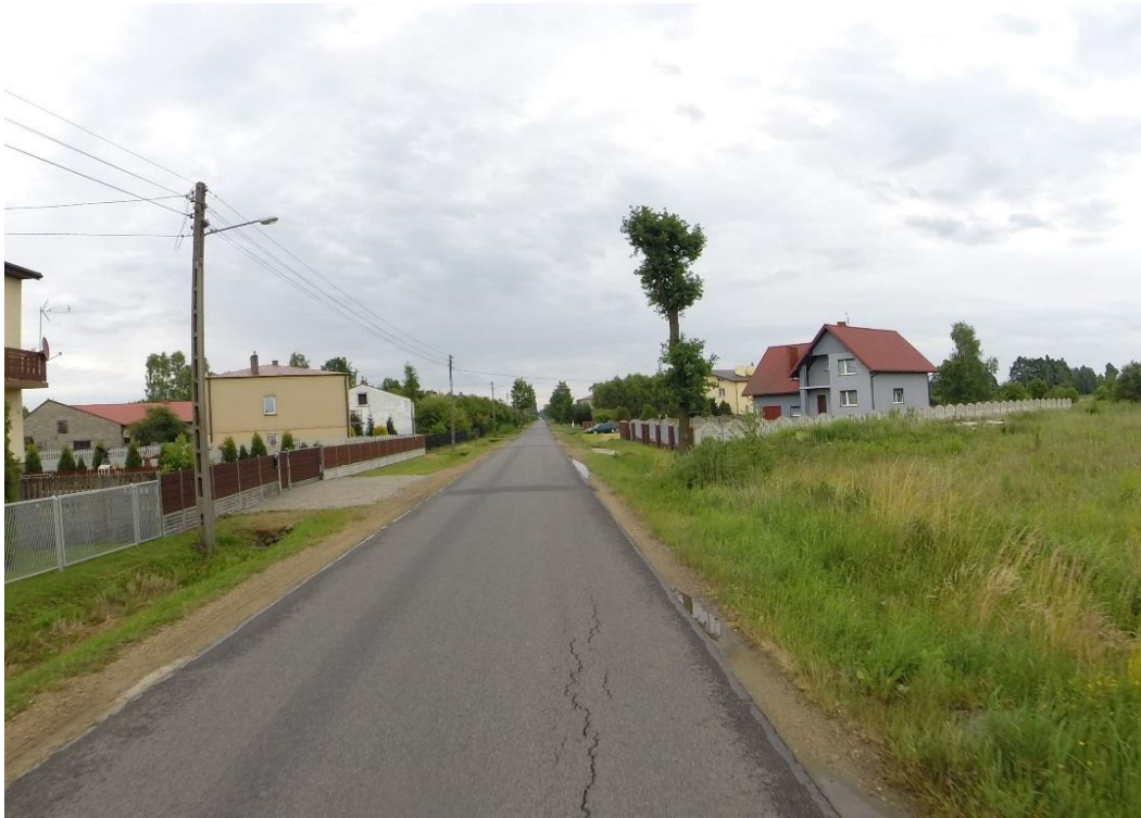
Zdj.34. DP 1056, Poczesna, ul. Łąkowa, gm. Poczesna przed przebudową
