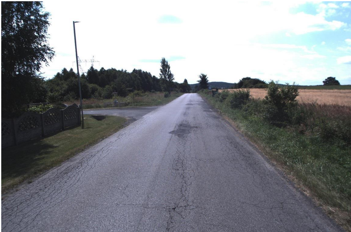
Zdj.32.DP 1037 S odc. Siedlec – Srocko przed przebudową
