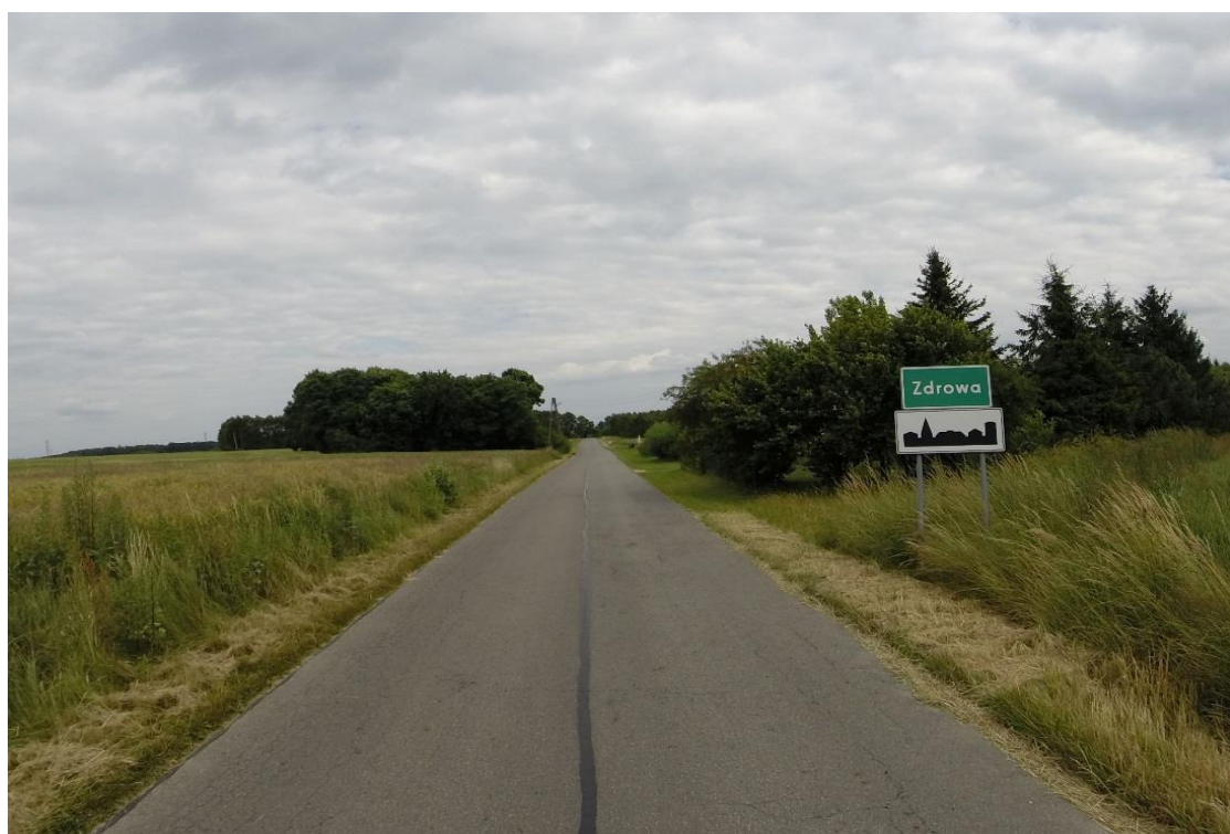
Zdj.29.DP 1070S odc. Baby – Zdrowa, gm. Kłomnice przed przebudową
