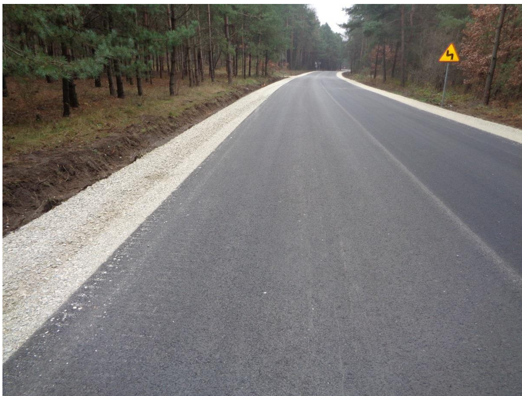
Zdj.46.DP 1013S, gm. Kamienica Polska droga po przebudowie
