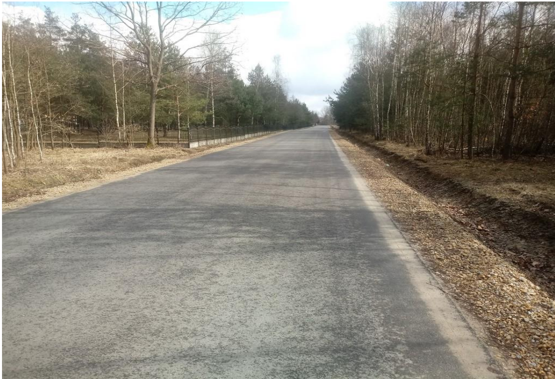
Zdj.25. DP 1056 S po przebudowie
