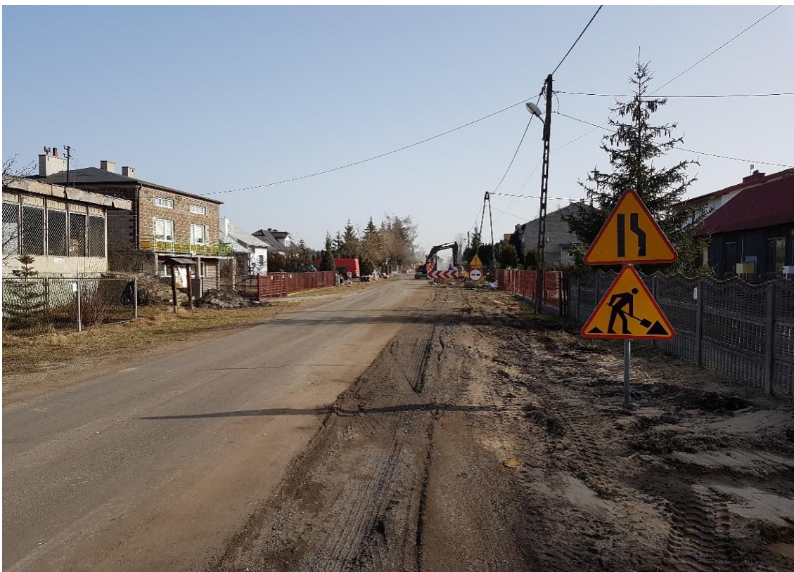
Zdj.48. DP 1042 S m. Kusięta – chodnik w trakcie budowy
