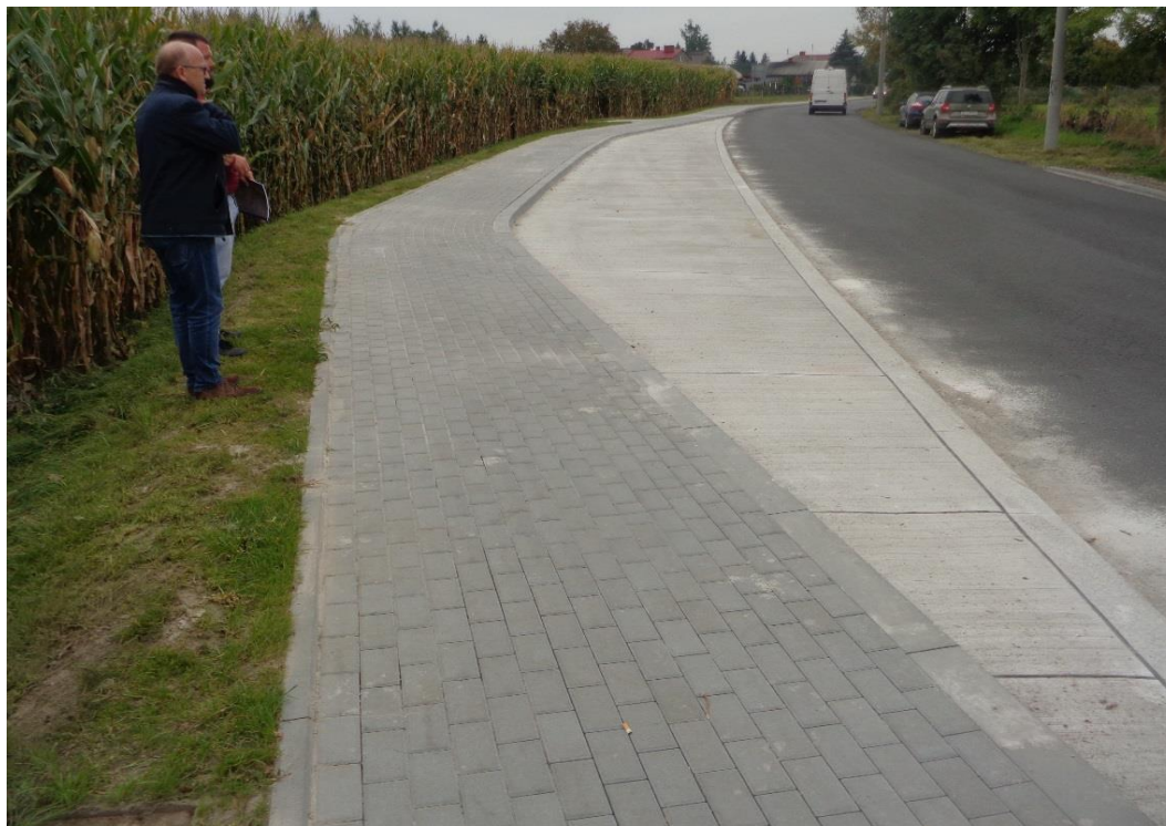
Zdj.44.DP 1019 S, gm. Kłomnice zdjęcie wybudowanej zatoki autobusowej
