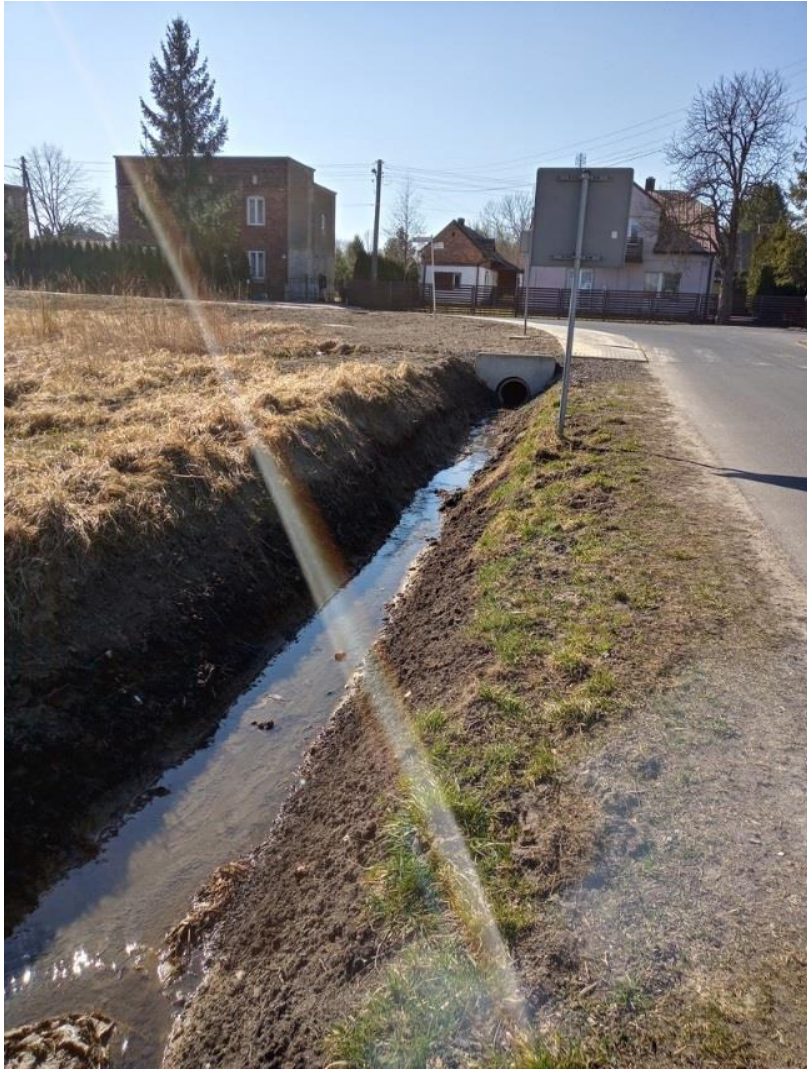
Zdj.53. DP 1062 S Korwinów rów odwadniający po przebudowie
