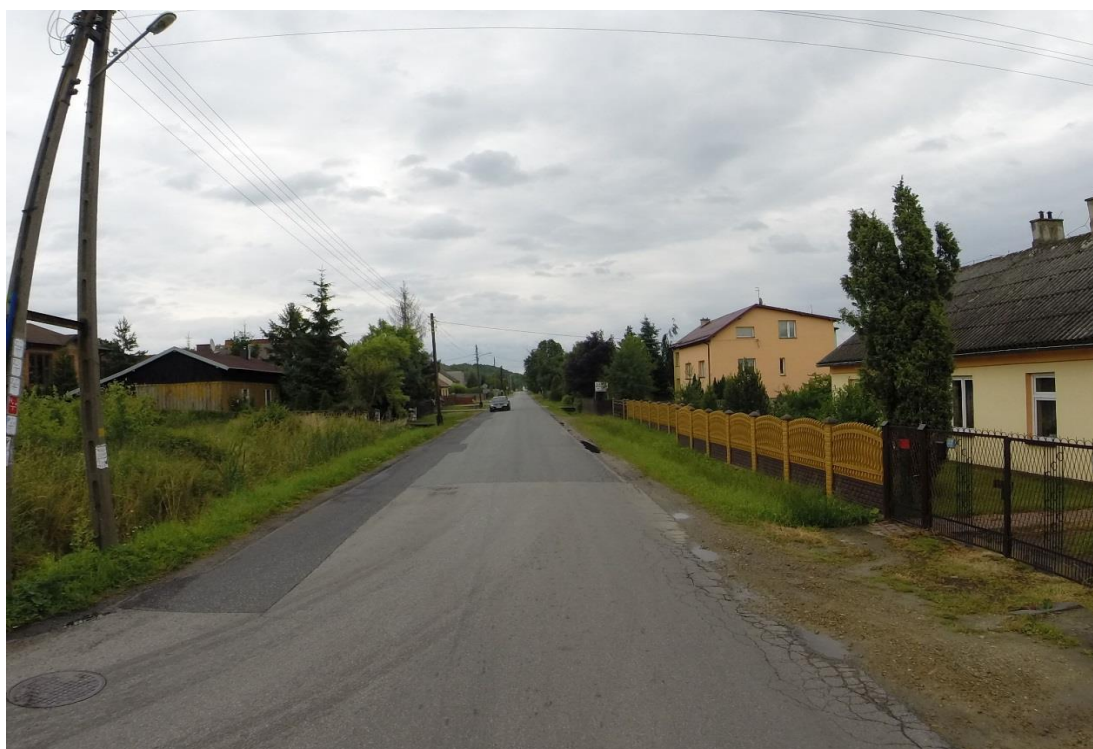
Zdj.22. DP 1057, Huta Stara A, ul. Tkacka, gm. Poczesna po przebudowie
