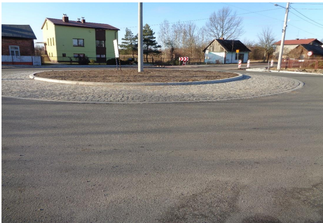
Zdj.21. DP 1057, Huta Stara A, gm. Poczesna rondo w trakcie budowy
