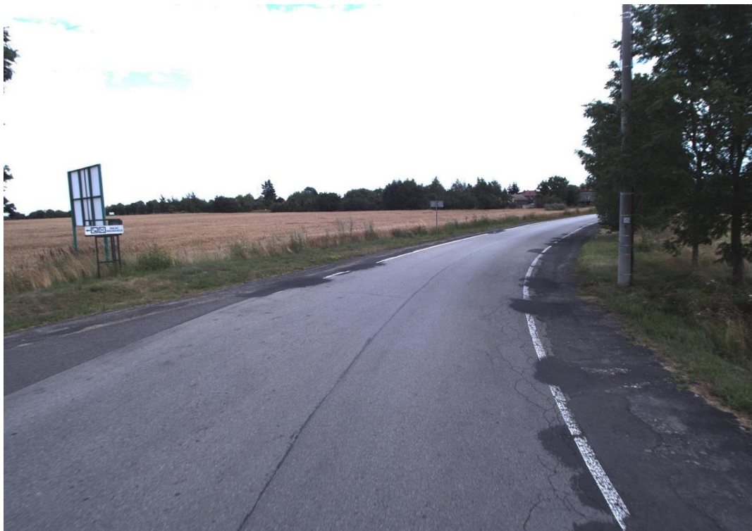
Zdj.43.DP 1019 S, gm. Kłomnice zdjęcie przed budową zatoki
