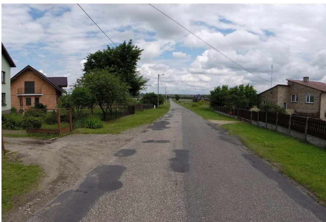
Zdj.39. DP 1093 S odc. Piasek – Czepurka droga przed przebudową
