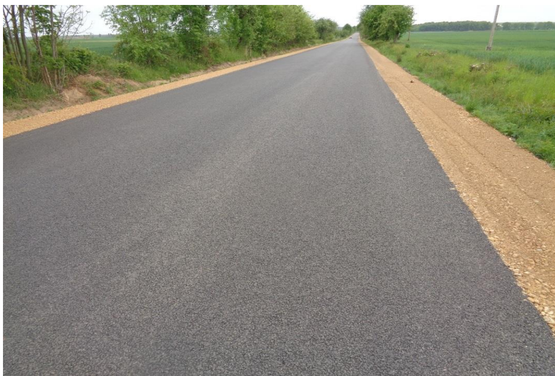
Zdj.28.DP 1025 odc. Borowno – Kruszyna, gm. Kruszyna po przebudowie
