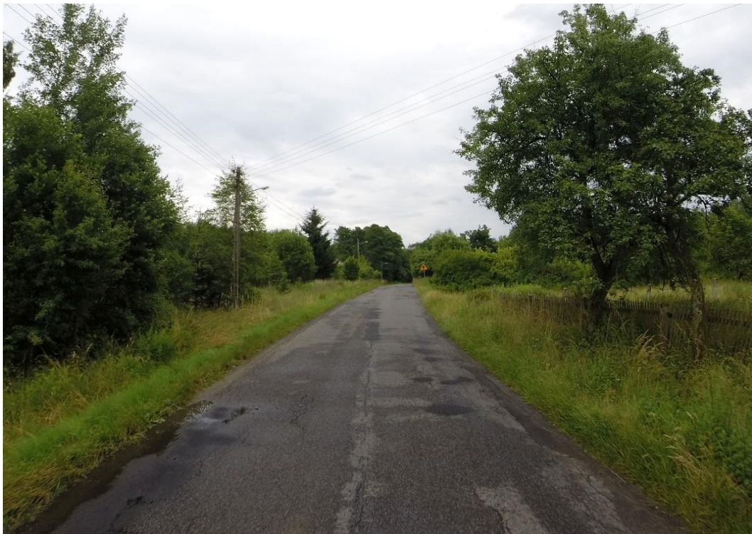
Zdj.35. DP 1056, Poczesna, ul. Łąkowa, gm. Poczesna przed przebudową
