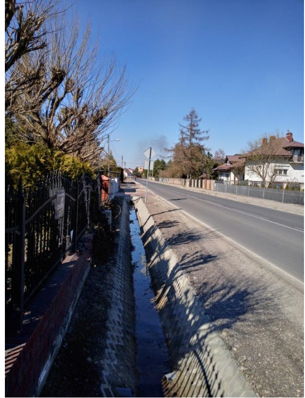
Zdj.51, 52. DP 1062 S Korwinów rów odwadniający po przebudowie
