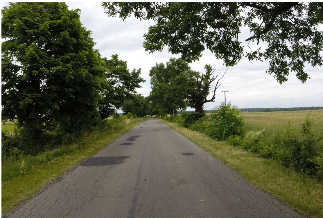
Zdj.26.DP 1025S, odc. Borowno - Kruszyna, gm. Kruszyna przed przebudową
