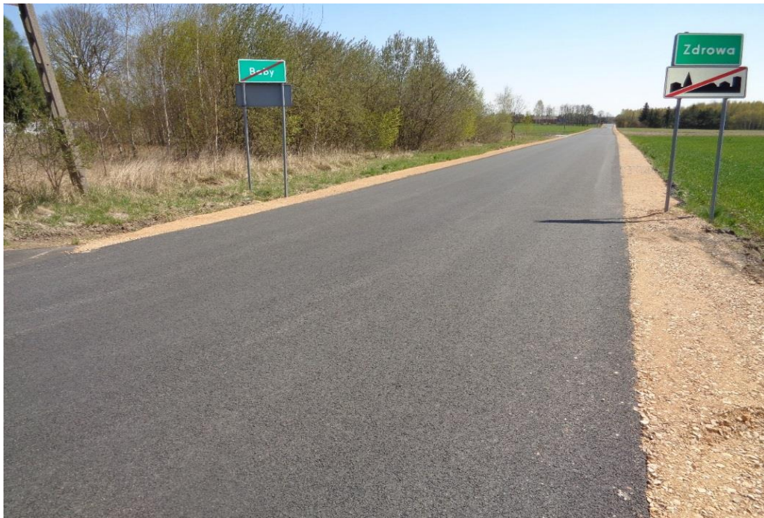
Zdj.31.DP 1070S odc. Baby – Zdrowa, gm. Kłomnice po przebudowie
