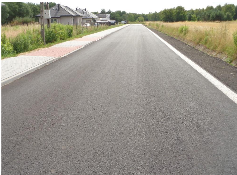
Zdj.45. DP 1008 S po przebudowie
