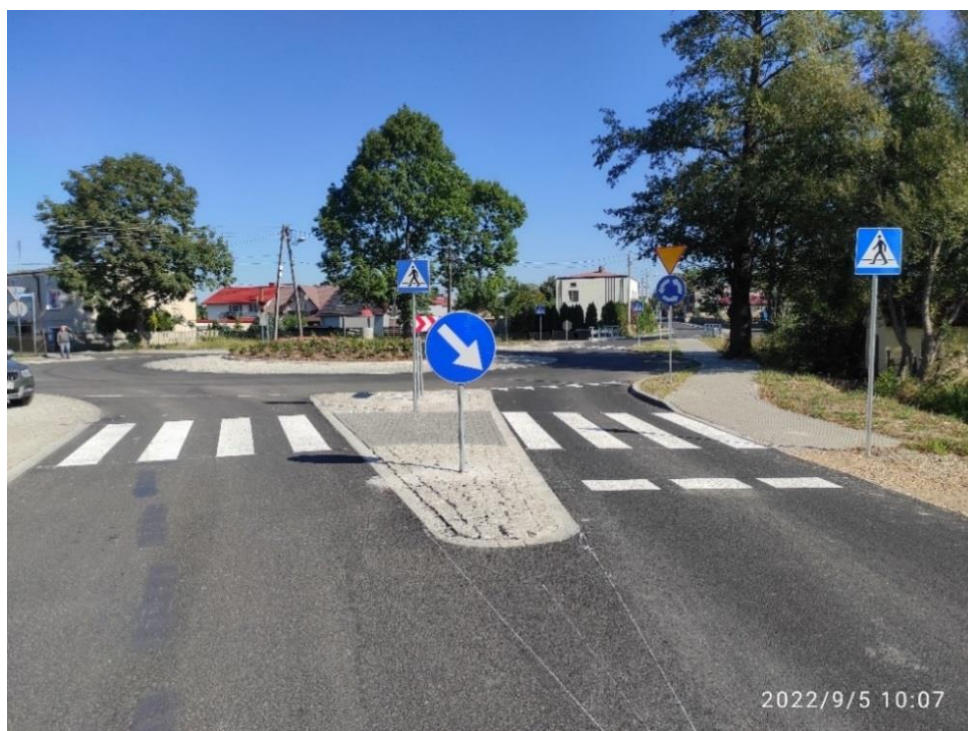
Zdj.39. DP 1025 S po przebudowie
