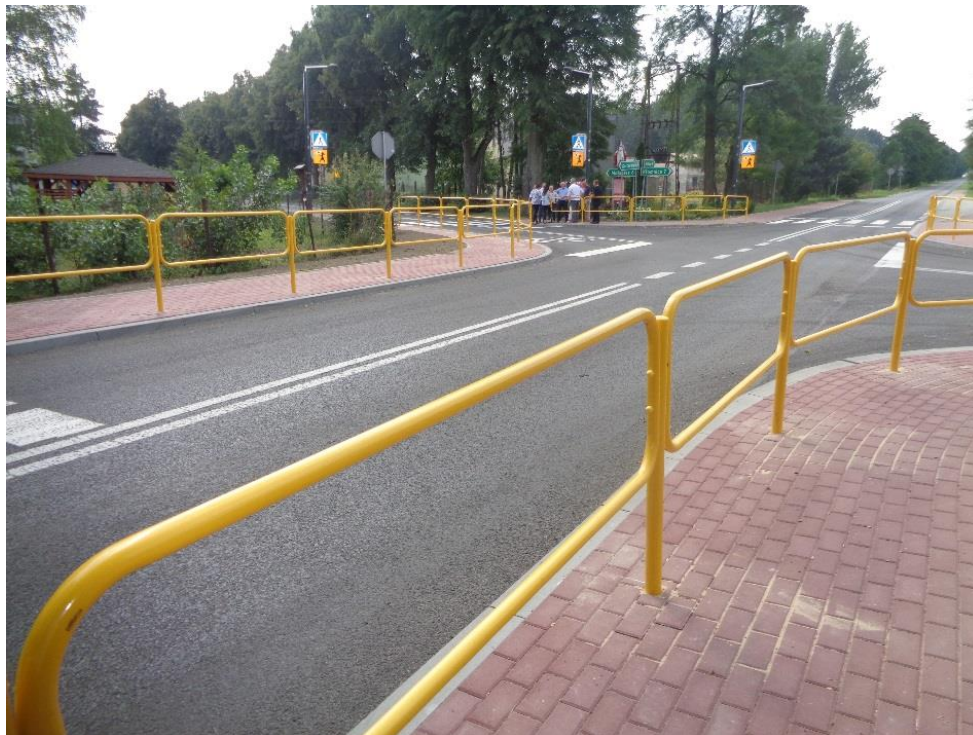
Zdj.42. DP 1024 S 1028 S po przebudowie
