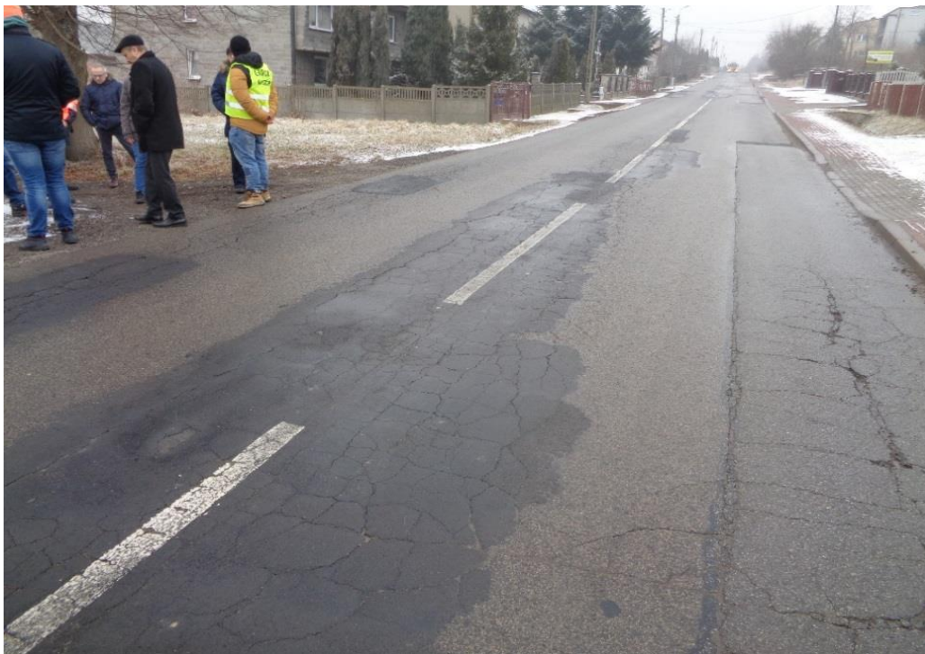
Zdj.46. DP 1054 S przed przebudową
