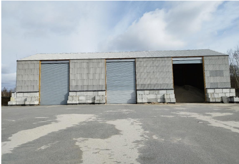
Zdj.69. Nowe rolowane bramy garażowe w magazynie soli w Konięcpolu
