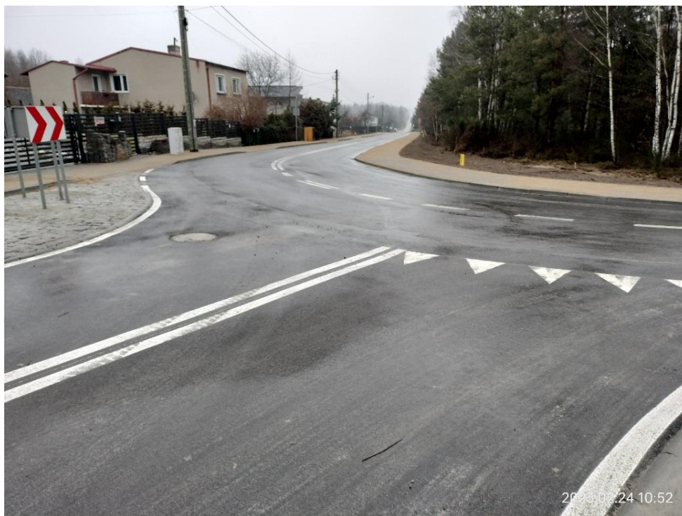
Zdj.49 DP 1054 S po przebudowie
