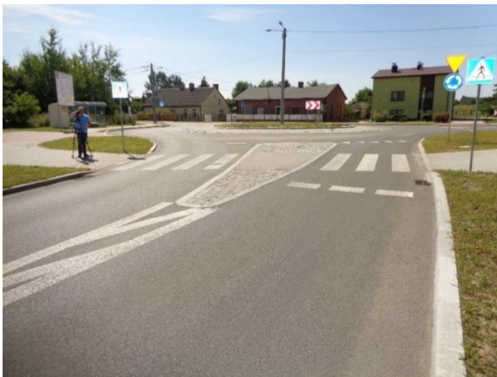
Zdj.37. DP 1057, Huta Stara A, gm. Poczesna droga po przebudowie
