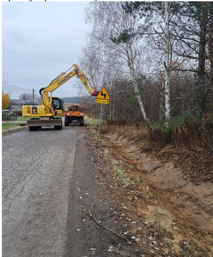
Zdj.55. koparki kołowej KOMATSU - renowacja rowów na DP 1016S w m. Bystrzanowice Dwór, gm. Janów
