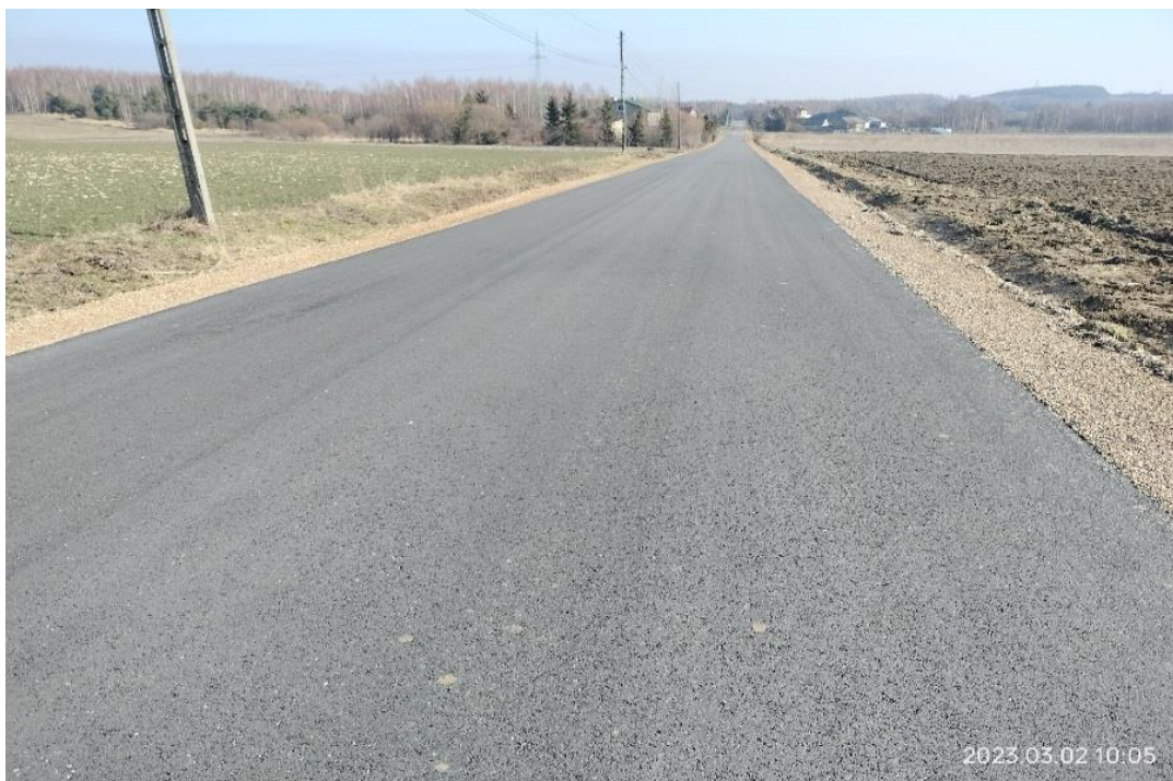
Zdj.51. DP 1069 S po przebudowie
