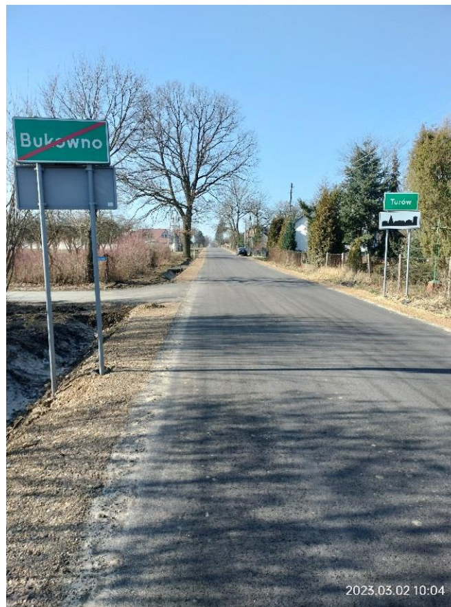
Zdj.50. DP 1069 S po przebudowie
