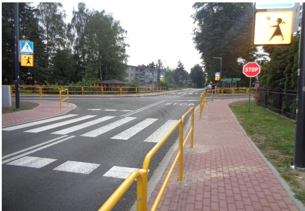
Zdj.43. DP 1024 S i 1008 S po przebudowie
