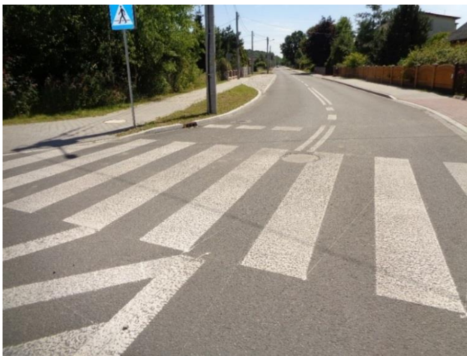
Zdj.36. DP 1057, Huta Stara A, gm. Poczesna droga po przebudowie
