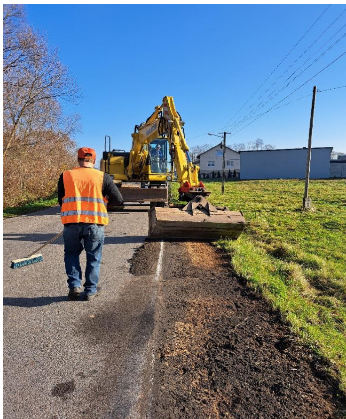
Zdj.56. koparka kołowa KOMATSU – ścinka poboczy na DP 1099S w m. Zagacie, gm. Koniecpol
