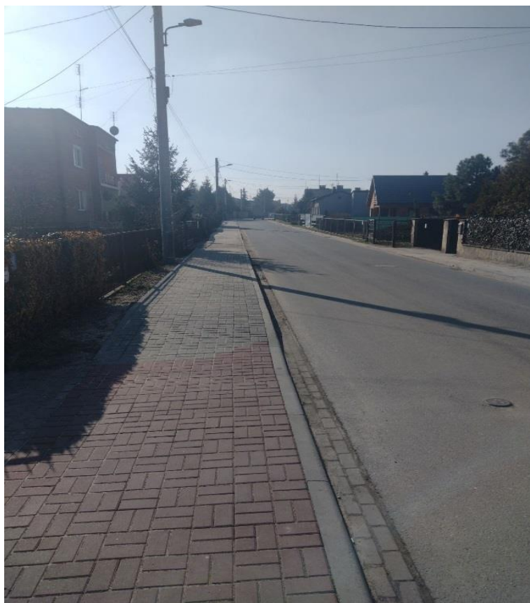
Zdj.53. DP 1069 S po przebudowie
