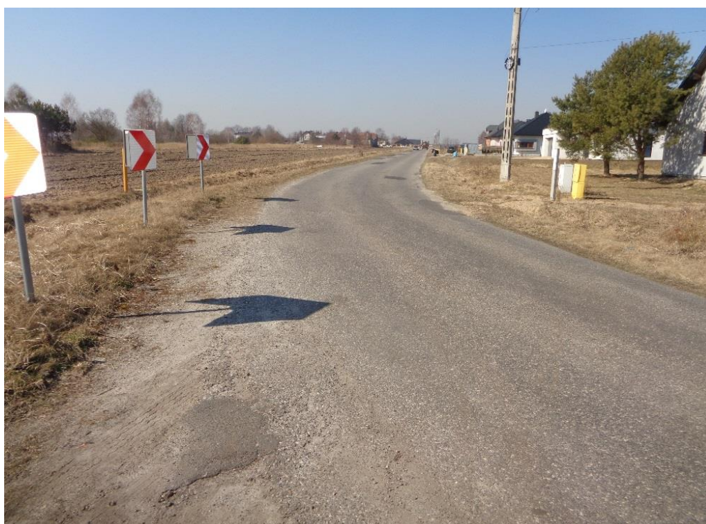
Zdj.44. DP 1008 S przed przebudową
