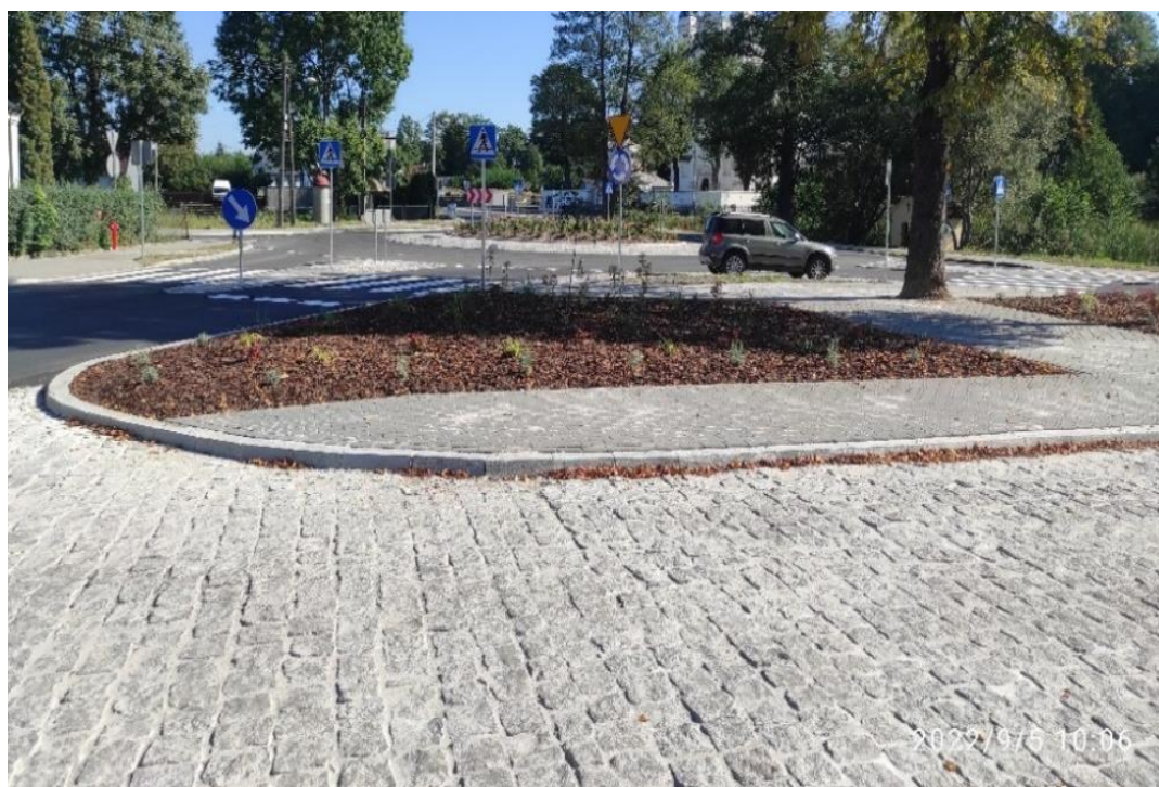
Zdj.38. DP 1025 S po przebudowie
