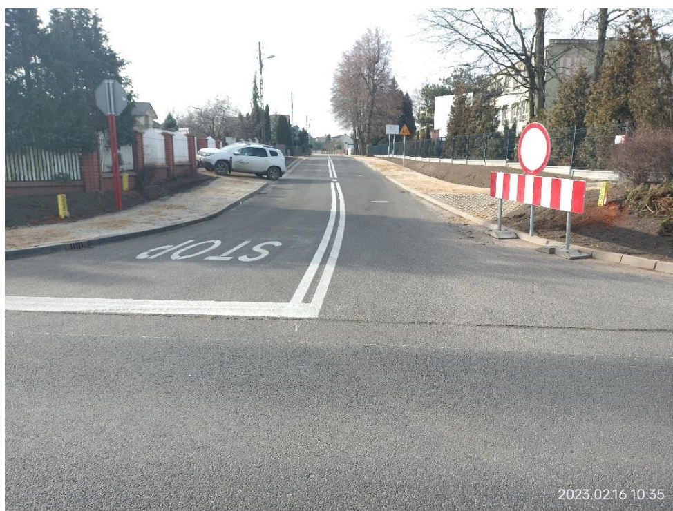
Zdj.48. DP 1054 S po przebudowie
