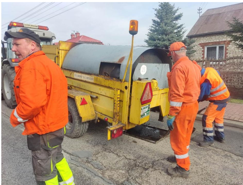
Zdj.61.Naprawa ubytków w jezdni przy użyciu recyklera na DP 1059 S w m. Kościelec, gm. Rędziny
