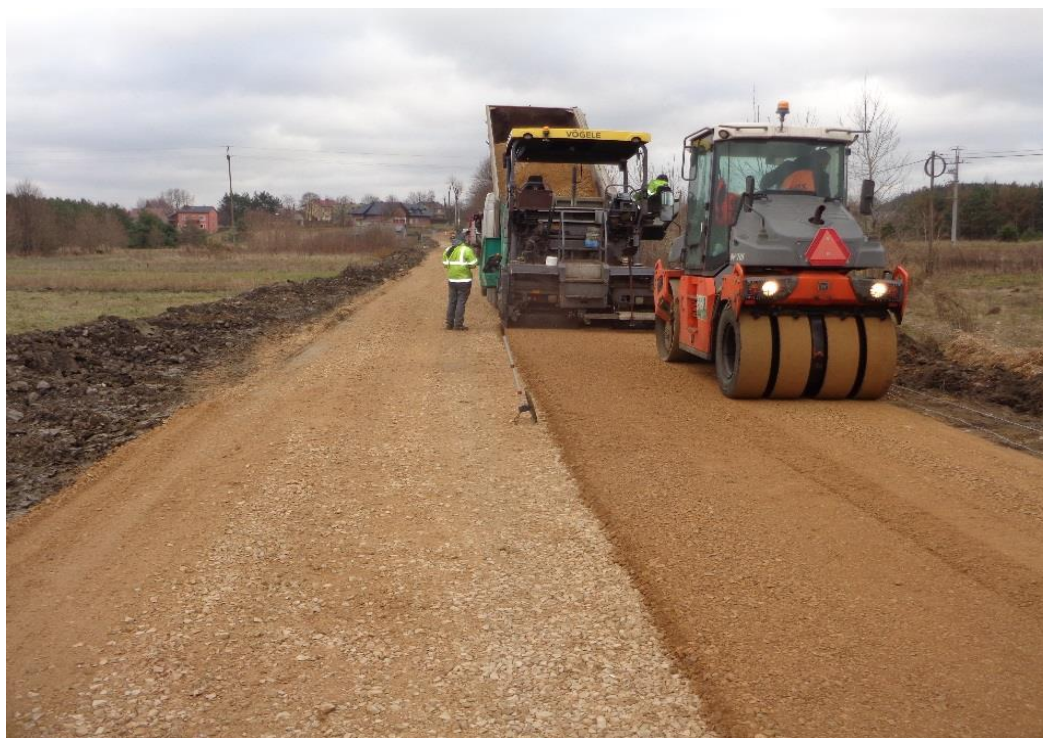
Zdj.41.DP 1093 S w trakcie przebudowy
